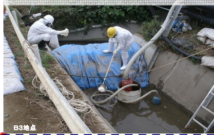
日排水路における土のうによるせき止めと水の回収
